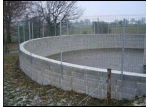
béton - bloc de coffrage
