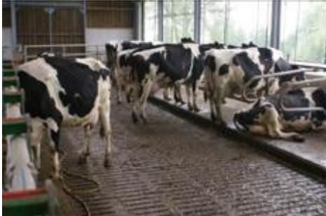
Les caillebotis constituent le système de production de lisier le plus répandu. A fentes ou à trous, ils couvrent le plus souvent le réservoir de stockage et permettent aux déjections de l'atteindre par gravité et par le piétinement du bétail. Les dimensions variables des dalles offrent de la souplesse pour la construction des couloirs et les largeurs des ouvertures sont fonction du bétail hébergé (porcs ou bovins).
